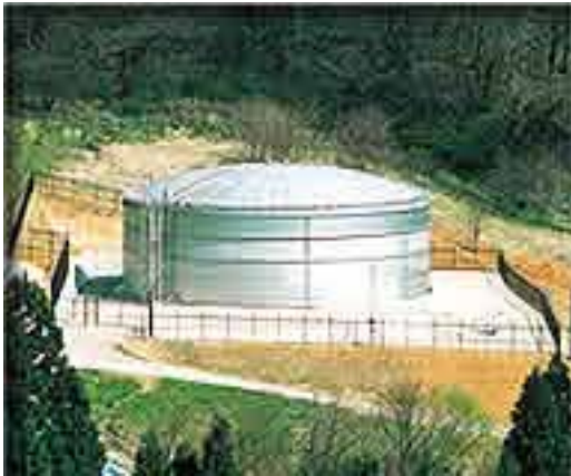
神林村上水道拡張工事 川部配水池（S U S 製 3600 m 3 ）築造工事 平成10年10月竣工
