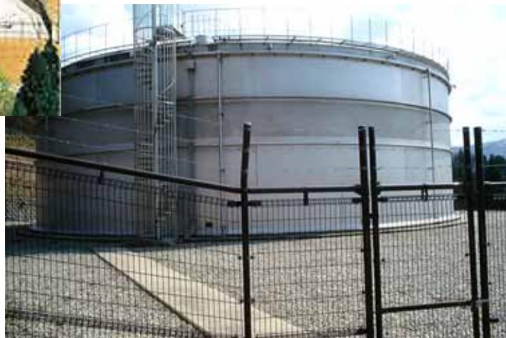
神林村上水道拡張工事 川部配水池（S U S 製 3600 m 3 ）築造工事 平成10年10月竣工
